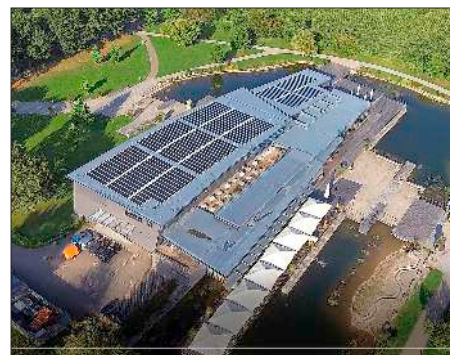
870 Quadratmeter groß sind die in die Dachhaut des KuB integrierten flexiblen Solarmodule.
