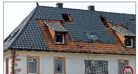
Ziegel vom „Grünen Baum“ wurden bereits teilweise entfernt.
