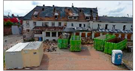
Mit Großcontainern wird das Abrissmaterial fachgerecht entsorgt. Fotos: Helmut Gall
